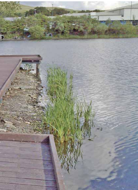
Steganlage mit Hangbefestigung aus hanit®
