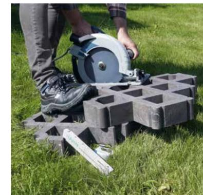
En plus de leur poids nettement plus faible, les utilisateurs apprécient leur résistance à la rupture et leur flexibilité lors de la pose. En effet, les dalles gazon **hanit®** peuvent être facilement coupées à la scie sur mesure.
