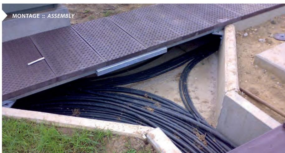
Die Montage der Kabelkanal-Abdeckplatten erfolgt durch unser qualifiziertes, elektrotechnisch unterwiesenes Fachpersonal (EuP).
