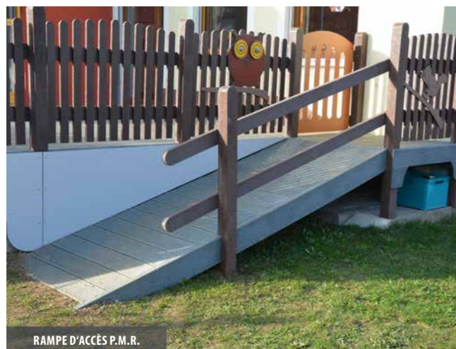
RAMPE D'ACCÈS P.M.R.
