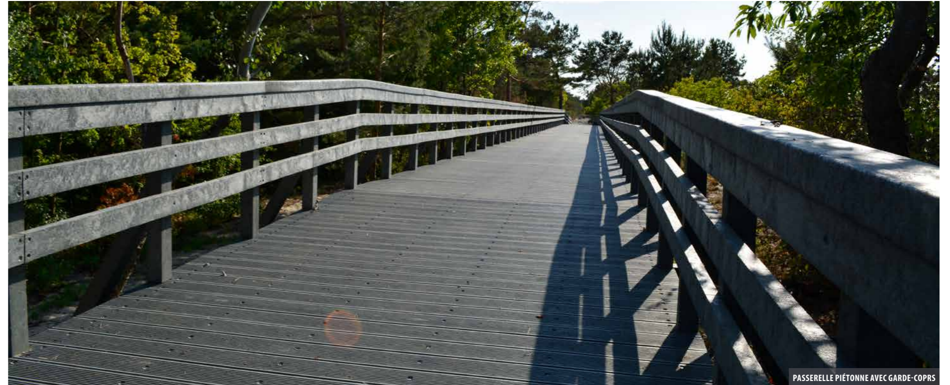
PASSERELLE PIÉTONNE AVEC GARDE-CORPS
